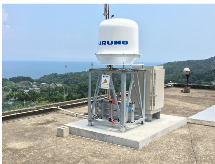
図 2-2 レーダの設置状況。鹿児島県立錦江湾高等学校に設置したもの
