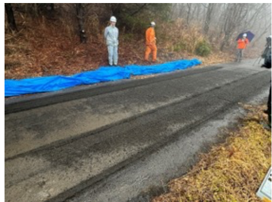
図 3-22 火山礫厚さ約 3cm の除去状況
